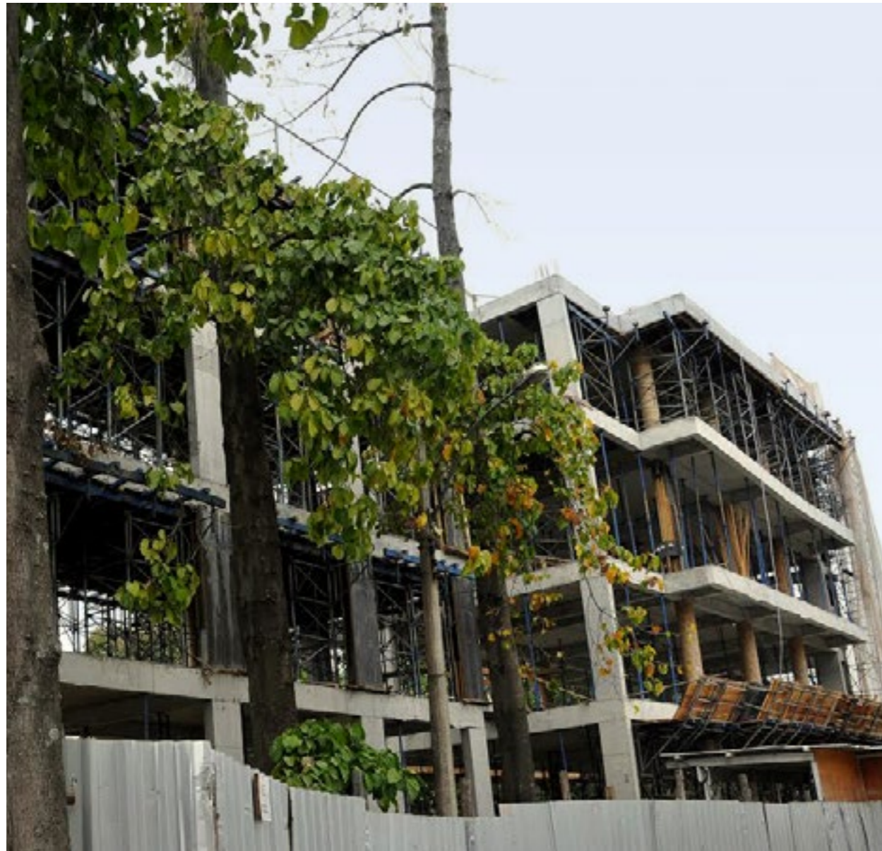
Centro de Documentação e História da Saúde (CDHS) em construção. O projeto da edificação obteve o Selo Procel e recebeu a nota máxima do Programa Nacional de Eficiência Energética em Edificações (Procel Edifica).
